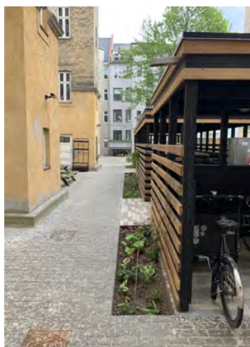
Regnbede anlagt langs cykelskure
