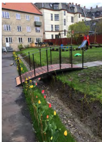
Grøften fra s. 14 som nyanlagt.
