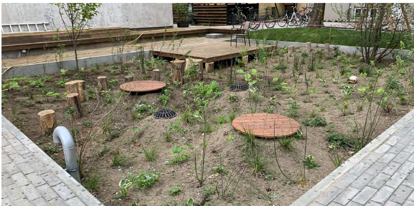
Et nyanlagt regnbed med mulighed for både ophold og leg. Foto: Gökhan Kuvvetli
